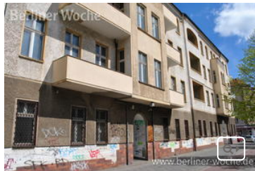
Eine Lösung für geflüchtete Kinder? Das hier noch leere Haus in der Frankfurter Allee 187 soll als Bildungsort dienen, damit die Kleinen in den Unterricht können. (Foto: Wrobel)
